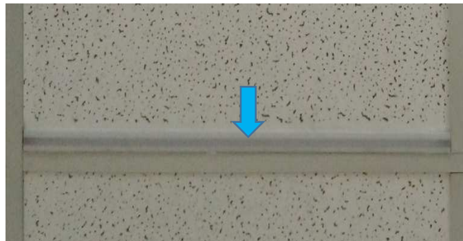
图 8：安装完成图。（轻钢架龙骨灯以蓝色箭头表示之 ← ）
